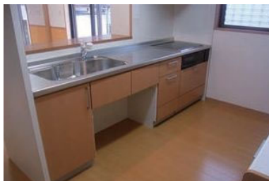
車いすでも洗い物ができるシステムキッチンを設置
