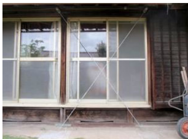
窓位置にも施工可能
