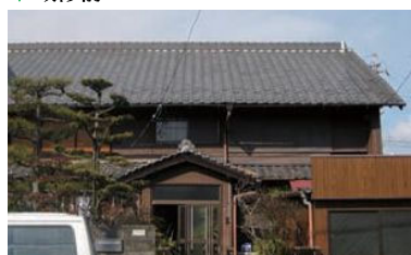
既設の日本瓦を撤去後、屋根をカラータングラスにして軽量化
